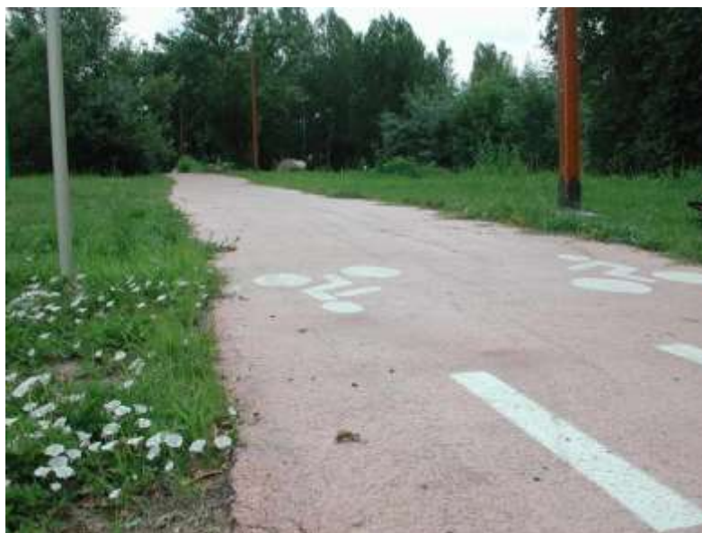
Exemple de piste cyclable à double sens (Cornebarrieu)
