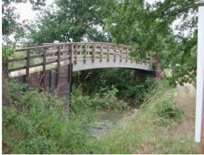
Quelques réalisations de passerelles
